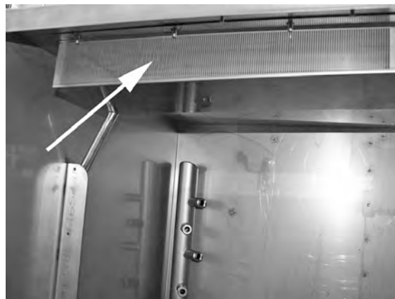
Figura 34 EcoExchanger visto dall'interno della cabina della macchina
